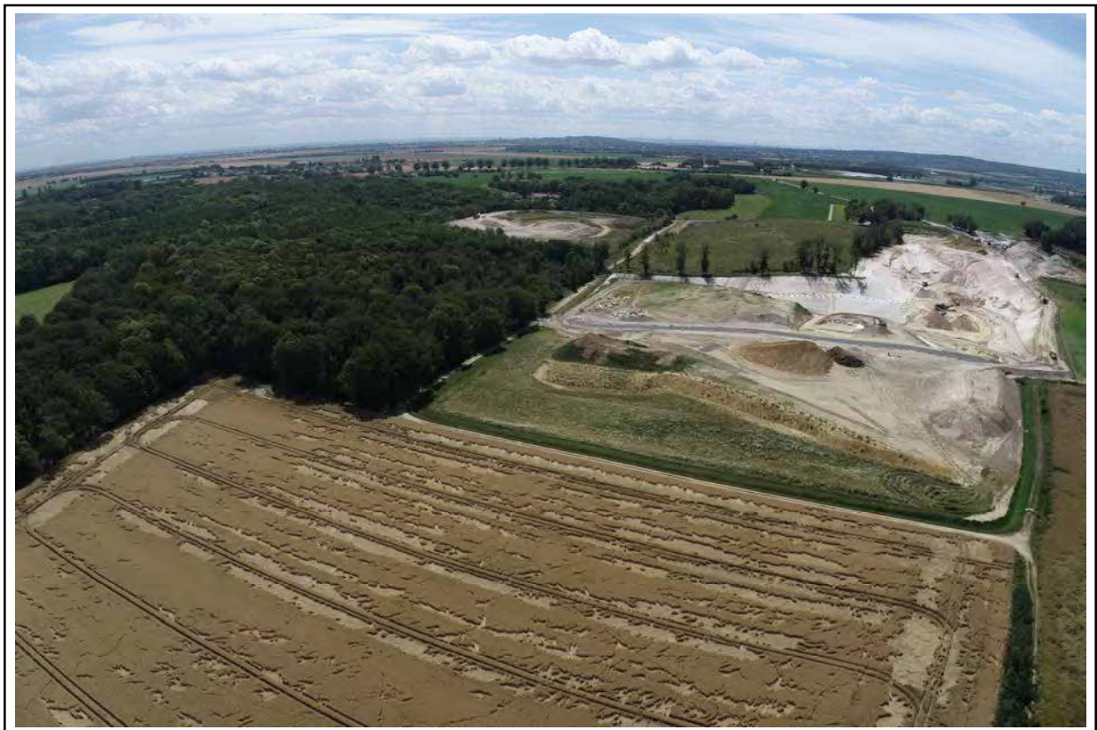
Vue aérienne de l'exploitation actuelle depuis le Nord (03 juillet 2023).
