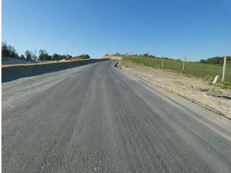
Nouvelle piste interne revêtue en enrobé (septembre 2023).
