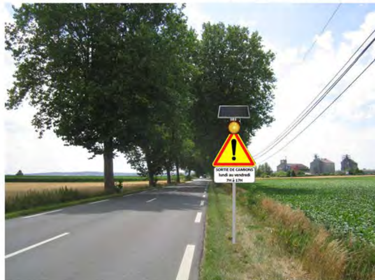
Mise en place d'un panneau de danger mono-flash autonome avec Batterie solaire Sens Villaines-sous-Bois > Attainville, position exacte à définir
